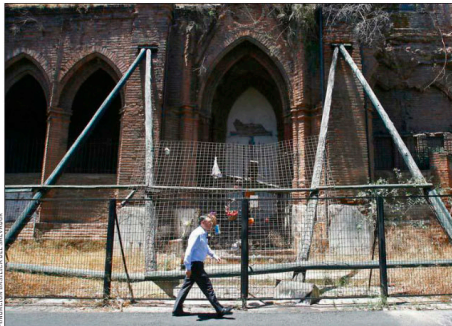
Así se ve la cara que da a Almirante Barroso: las estacas de emergencia que sostienen el muro, la reja que impide circular por la vereda contigua. La persona en la foto camina de norte a sur.
